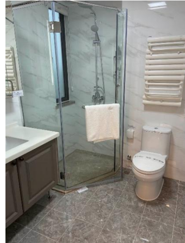
样板间-卫生间
